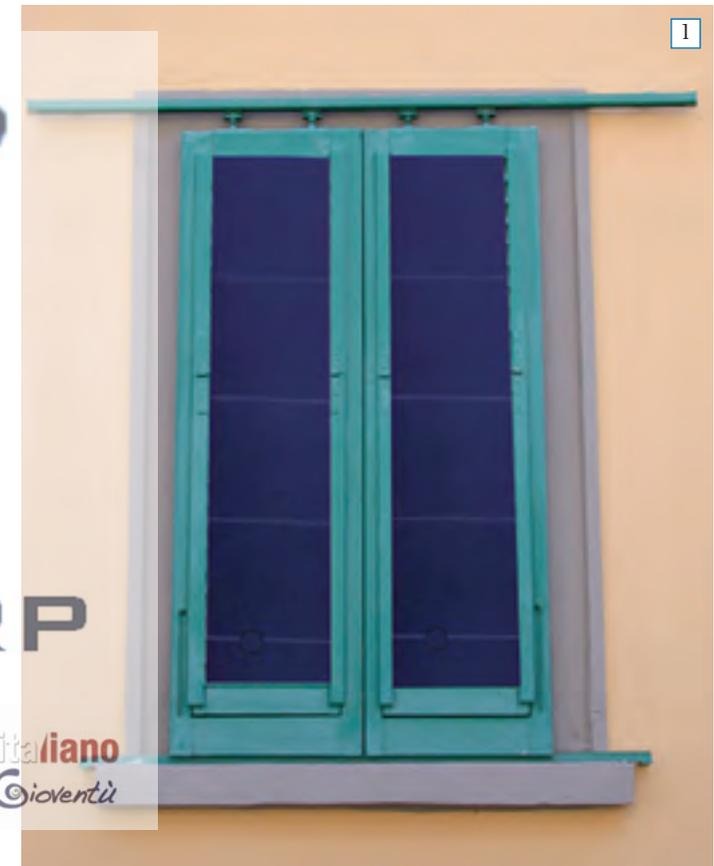
Fig. 1 - Prototipo Persiana solare
